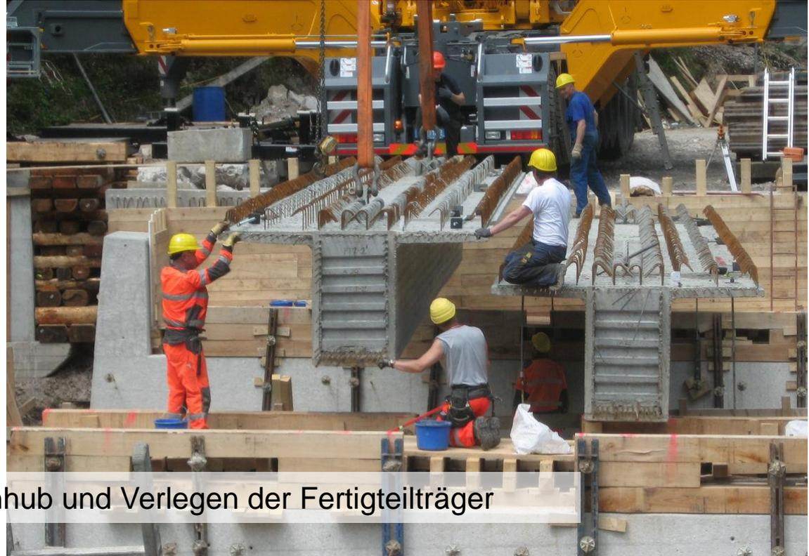
Einhub und Verlegen der Fertigteilträger
