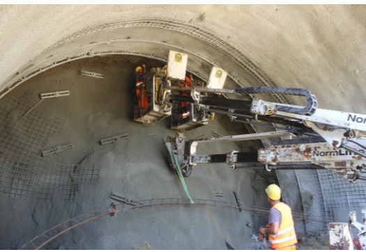
Sicherungsarbeiten Nordportal
