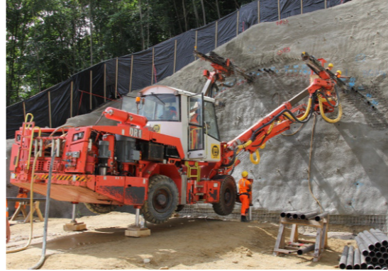
Herstellung Rohrschirm für Tunnelanschlag
