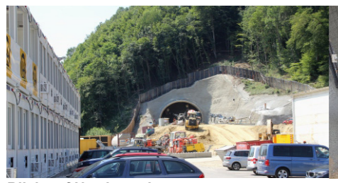
Blick auf Nordportal
