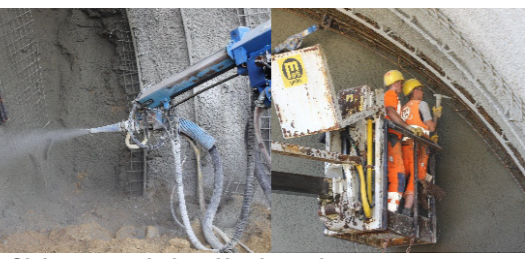
Sicherungsarbeiten Nordportal
