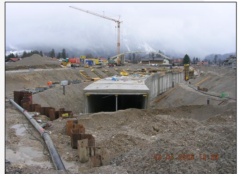
Beispiel: Baustelle Schlosstunnel Ruhpolding (einbahniger Querschnitt, kein Grundwasser)
