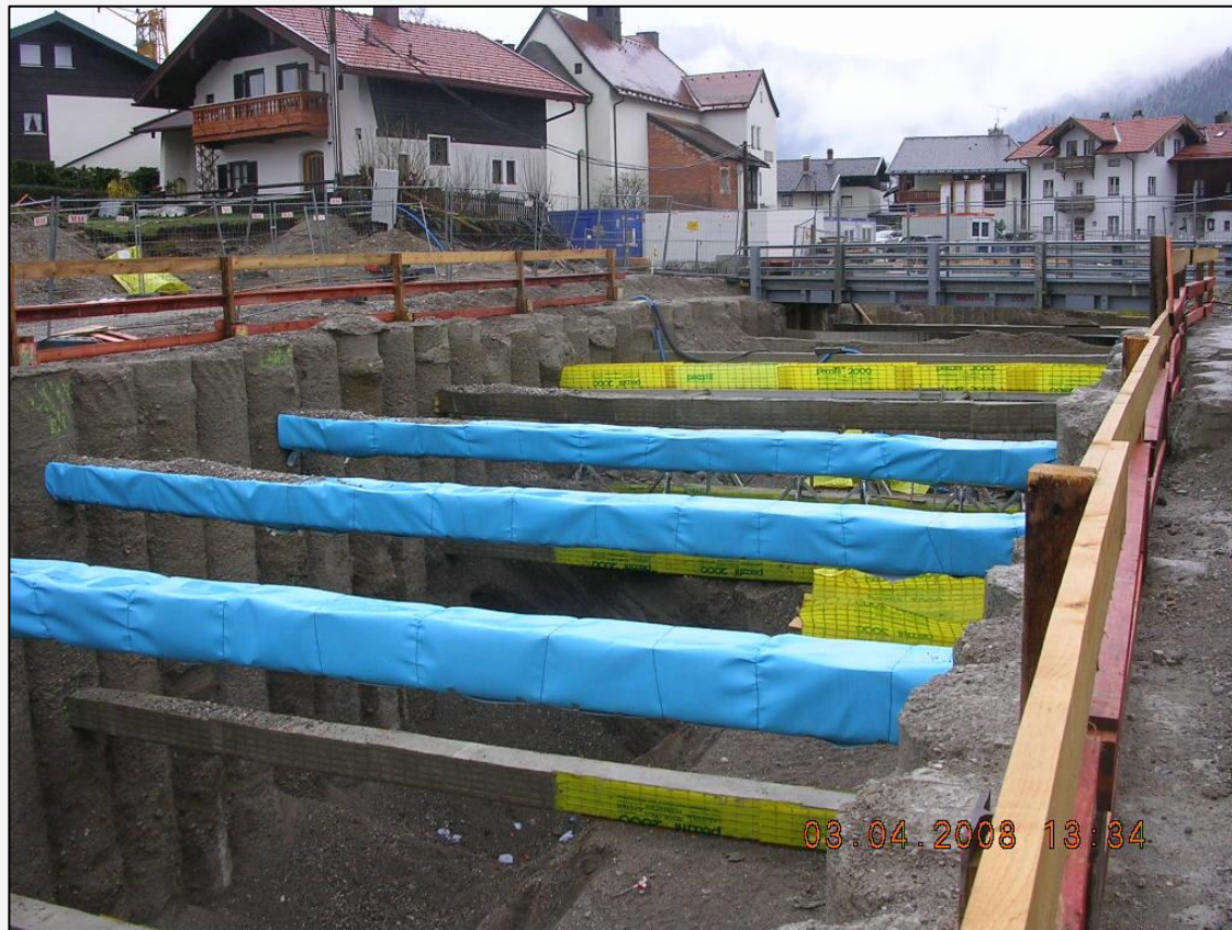
Beispiel: Baustelle Schlosstunnel Ruhpolding (einbahniger Querschnitt, kein Grundwasser)
